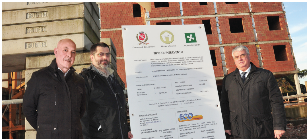
Gli assessori Pomari e Melzi e il sindaco Borgonovo di fronte al cantiere Aler fra via Dante e via Libertà.
